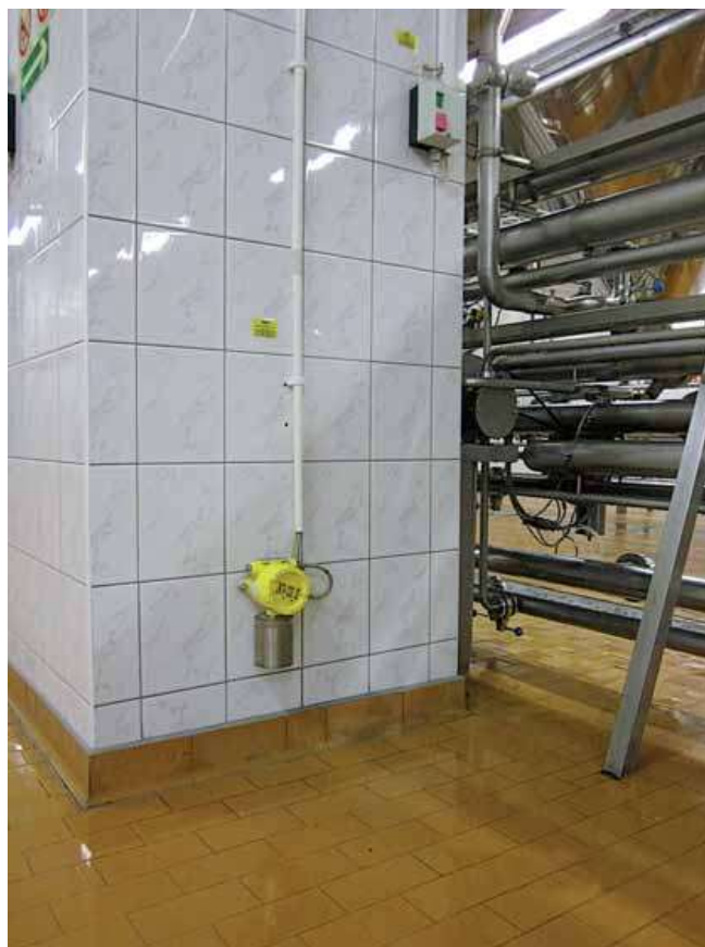
► Detektor CO 2 w osłonie bryzgoszczelnej
